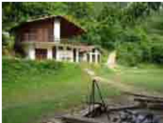
Bâtiment du CCJura / Gardien
